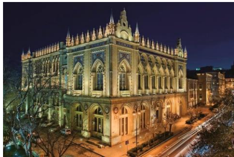
Bakı. İsmailiyyə binası (memar İ.Ploşko, 1907-1913-cü illər)
