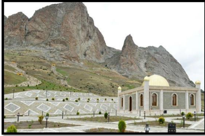
Şəkil 6. Əlincəqala və qala ərazisində inşa edilmiş muzey binası. Naxçıvan MR Culfa rayonu
