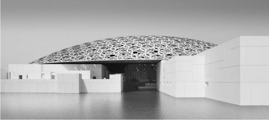
Şəkil 3. Jan Nouvel Luvr Əbu-Dabi nəhəng həndəsi günbəzlə örtülmüş giriş
